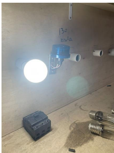
Foto 02: Teste em relé retirado da luminária.
